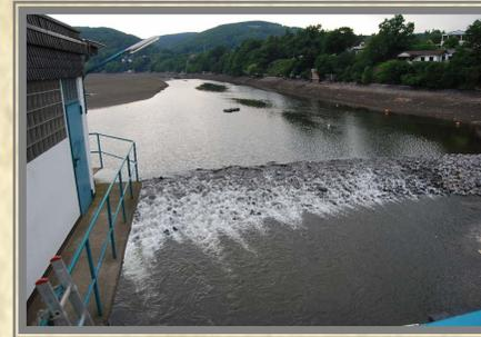
Um die Arbeiten an der Wehrschwelle und an den Wehrpfeilern durchführen zu können, musste der See abgesenkt werden.
